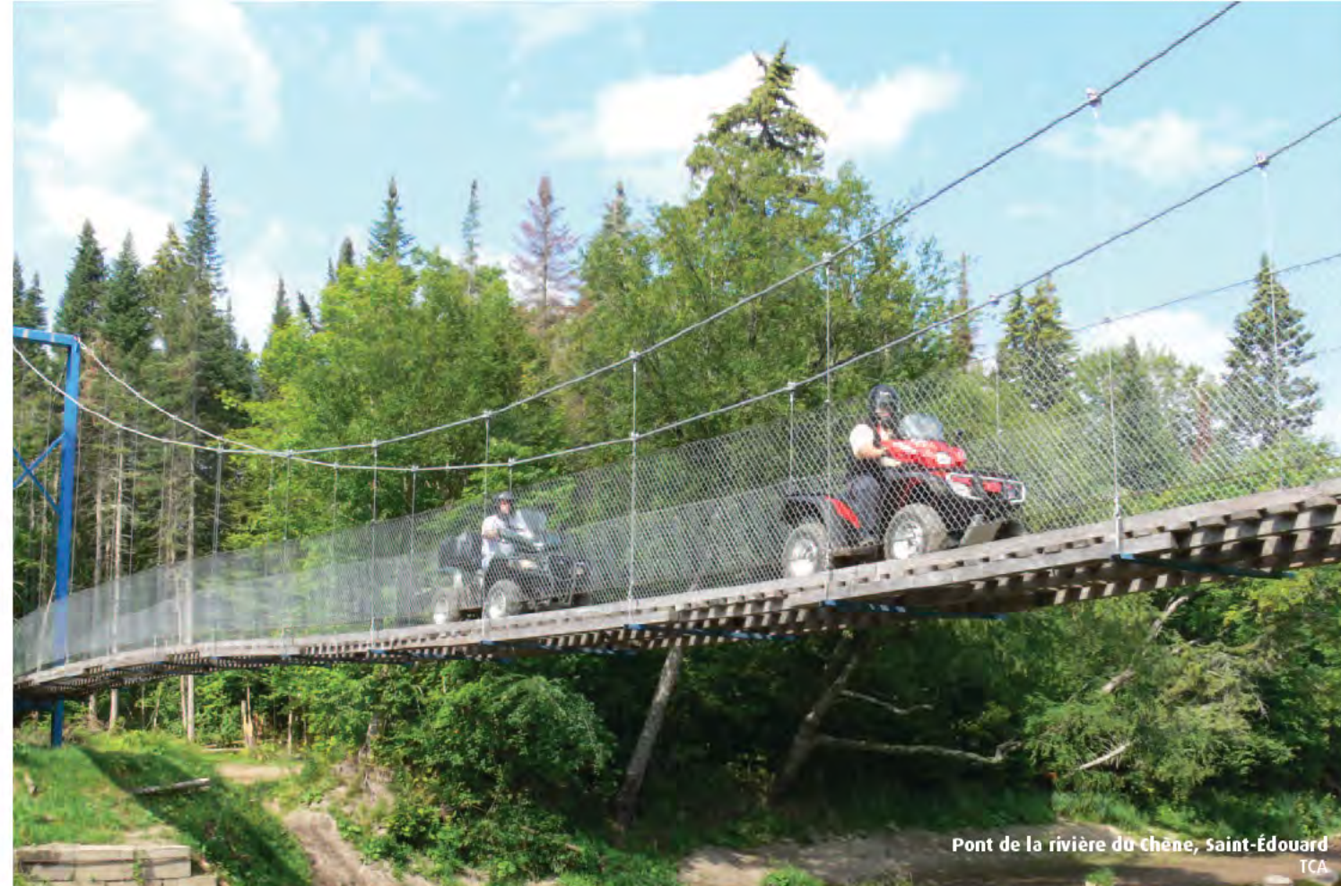
Pont de la rivière du chène, Saint-Édouard
